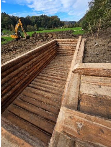
Abbildung 11: Sanierung Sickeranlage am Stolle
