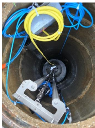
Abbildung 25: links: Elektroschrank mit Steuerschrank, rechts: Pumpenschacht mit neuer Installation
