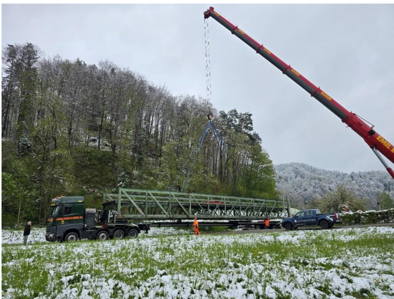
Abbildung 5: Aufladen alte Brücke
