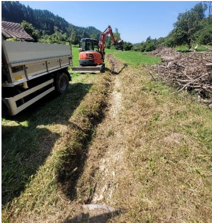
Abbildung 8: Reprofilierung Röslibach
