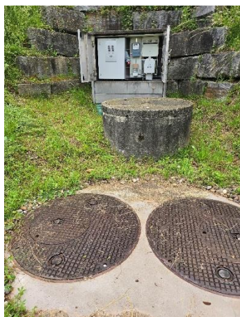
Abbildung 24: Pumpen- und Leitungsschächte im Vordergrund, im Hintergrund der Elektroschrank inkl. Steuerung
