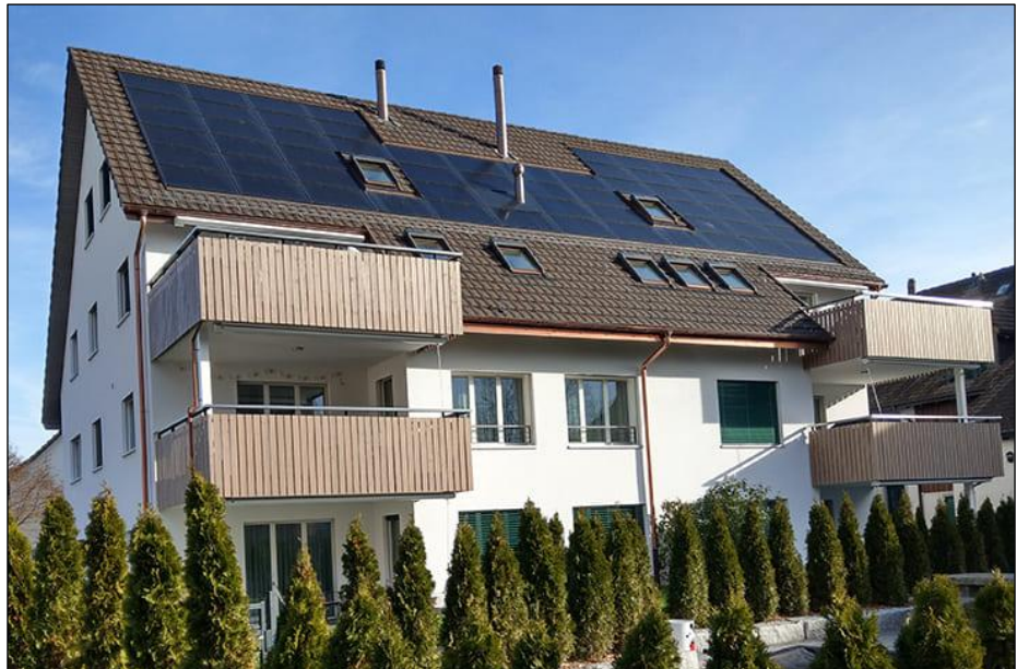
Abb. 14: Beispiel Indach-PV-Anlage. Eine bessere Einordnung wäre möglich, wenn die Dachfensterflächen mit den Modulen abgestimmt wäre (Quelle Abbildung: Axsun, https://www.axsun.de/referenzen/beispiele-indach-solarmodule , 10.11.2022)
