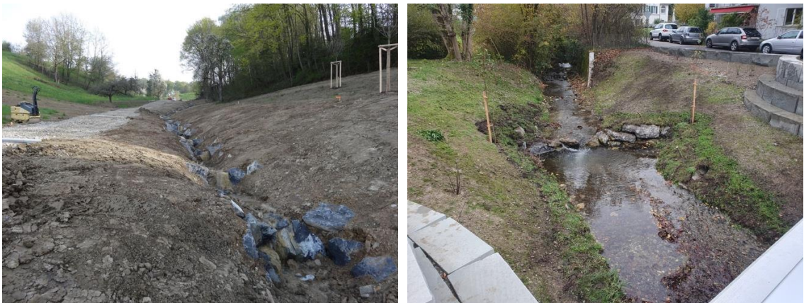
Abbildung 15: Schwellenverbau (Töbelibach) und Flankenbegrünung Schwelle (Äuss. Dollikerbach)
