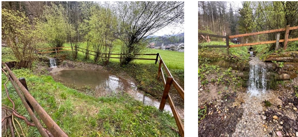
Abbildung 6: Geschiebesammler und Sohlswellen im oberen Projektabschnitt
