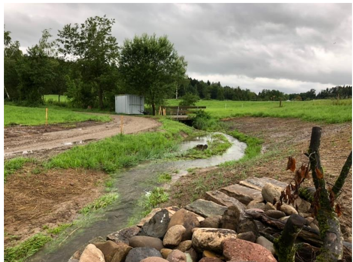
Abbildung 13: Periodisch überströmte Flutmulde bei Hoch- und Mittelwasser (Gossauerbach)
