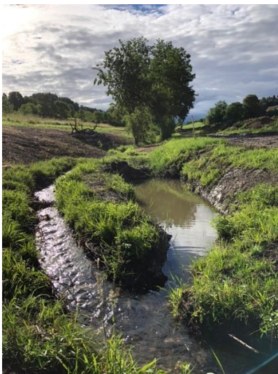
Abbildung 13: Periodisch überströmte Flutmulde bei Hoch- und Mittelwasser (Gossauerbach)
