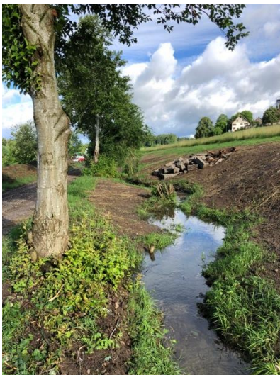
Abbildung 11: Gerinnegestaltung mit transplantierten Vegetationssoden (Gossauerbach ZH)
