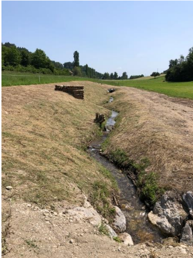
Abbildung 12: Böschungsbegrünungen mit Direktsaat (links) Böschungsfächen Folgejahr (rechts)
