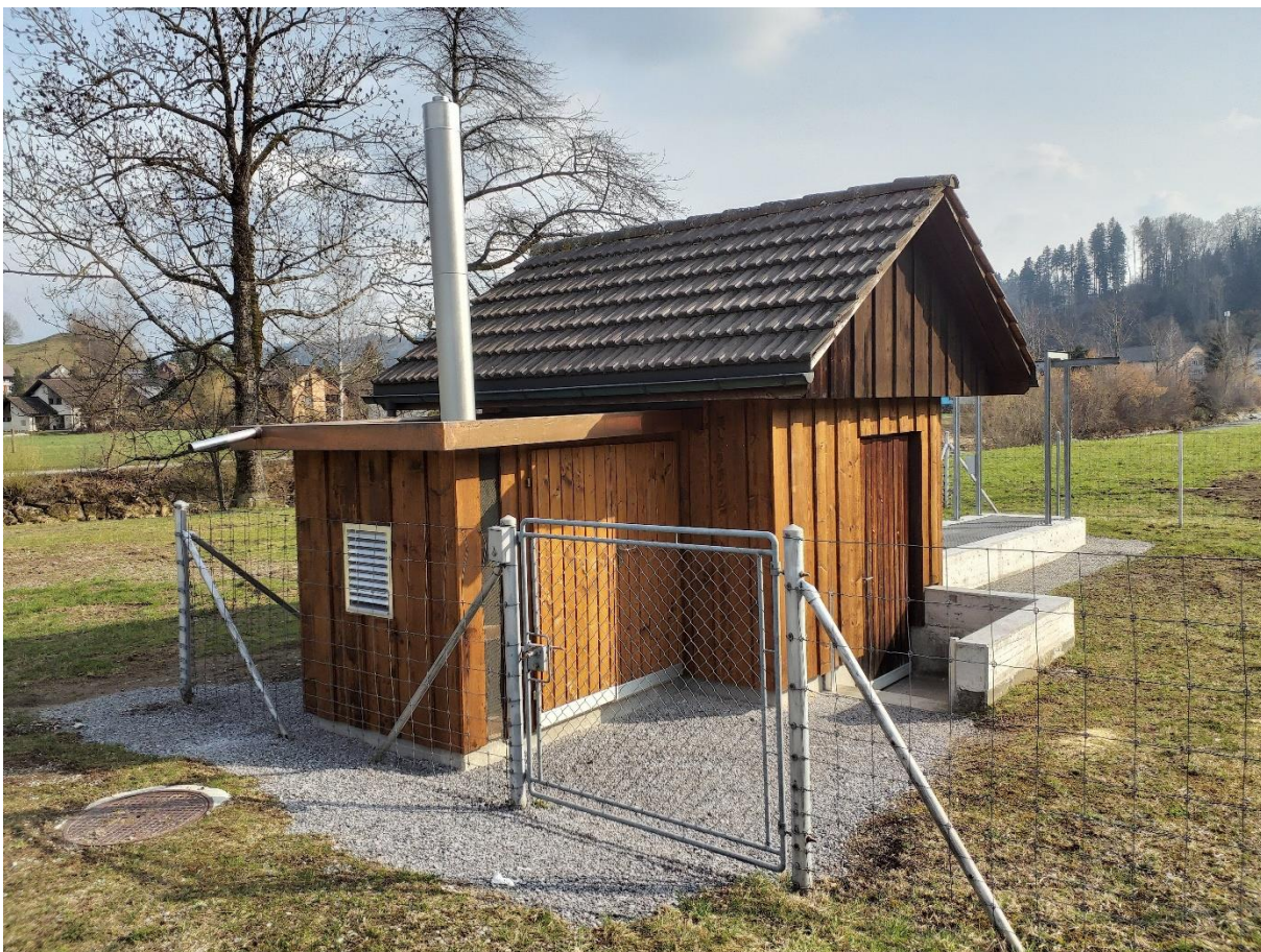
Pumpenhaus mit neuem Anbau, in dem das Notstromaggregat untergebracht ist. Gut sichtbar auch die um 40cm erhöhten Mauerkronen.
