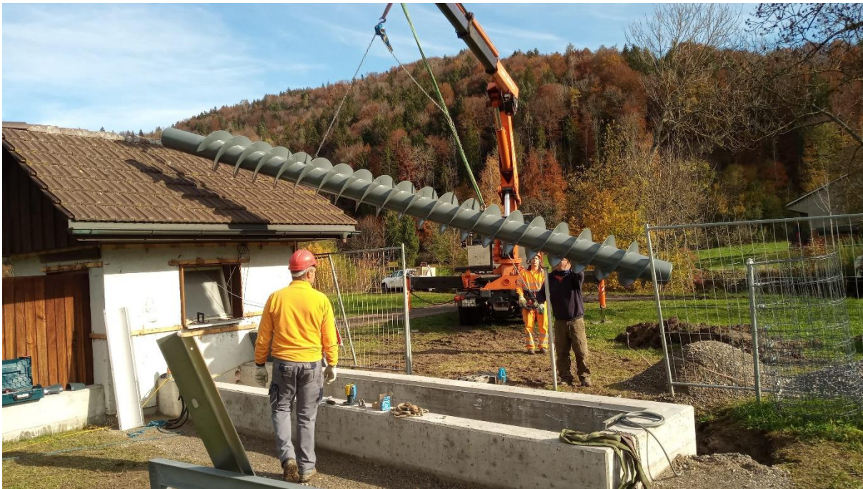
Montage der neuen Hebewerkschnecke
