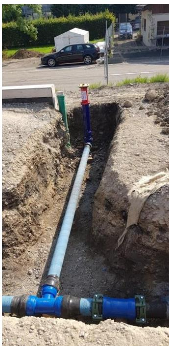
Aufgrund der neuen Führung des Rad- sowie des Fussgängerverkehrs im Raum des Bahnhofareales in Saland, musste die Hauptwasserleitung verlegt werden. Zudem wurde der Hydrantenstandort in Absprache mit dem Feuerwehrkommandanten optimiert.
