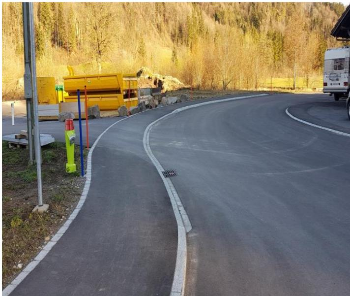
In Saland wurde, im Rahmen eines koordinierten Projektes mit dem Tiefbauamt des Kantons Zürich "Schliessung Radweglücke Saland", die Grob-Erschliessung zum künftigen Baugebiet Ischlag erstellt. Projektbedingt mussten Werkleitungen wie u.a. die Wasserleitungen verlegt, sowie in Absprache mit dem Feuerwehrkommandanten der Hydrantenstandort angepasst werden
