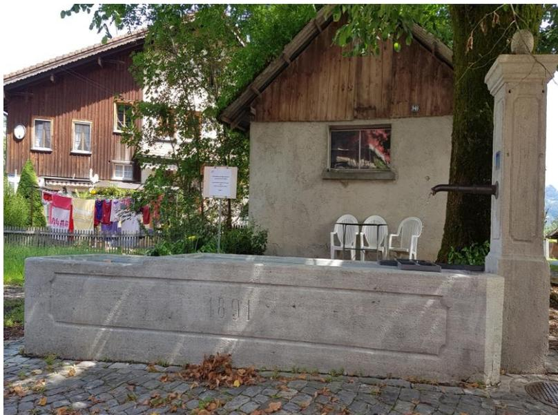
Der Dorfbrunnen Bliggenswil wies starke Kalkablagerungen aus, die den Algenbewuchs aufgrund der porösen Oberfläche stark begünstigte. Nach dem mechanischen Abtrag (Sandstrahlen) der Ablagerungen wurde der Brunnen wasserseitig mit einem Flächenspachtel versiegelt.
