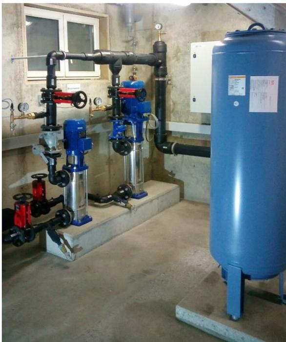
Neue Brauchwasseranlage, links Druckerhöhungspumpen, rechts Druckbehälter
