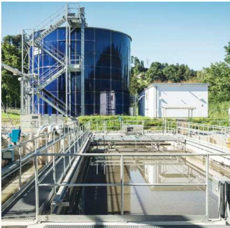
Sicht auf das Vorklärbecken mit den dahinter liegenden SB-Reaktoren
