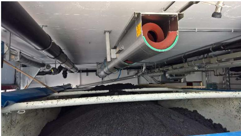
Blick in die Mulde mit dem entwässerten Faulschlamm
