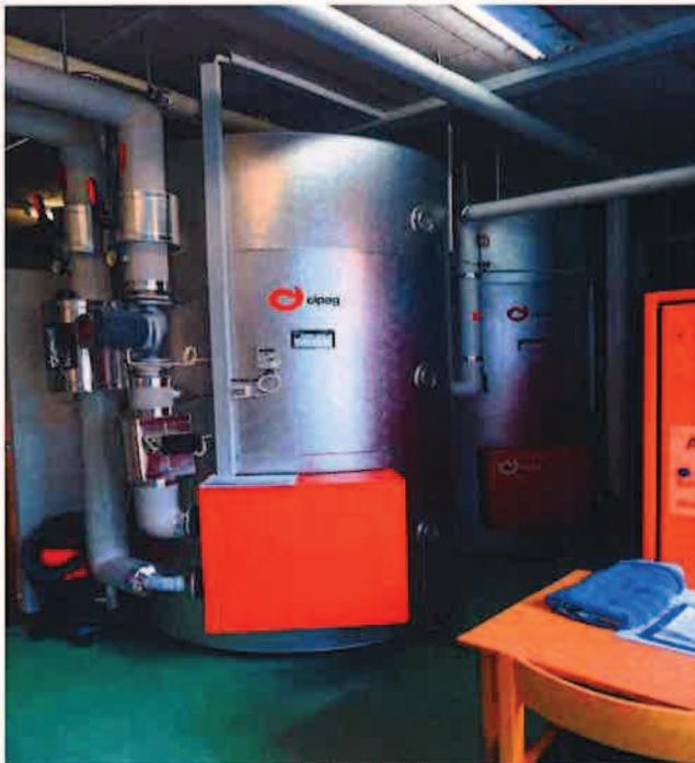
Abbildung 47: Warmwasseraufbereitung mittels Trinkwasserspeicher
