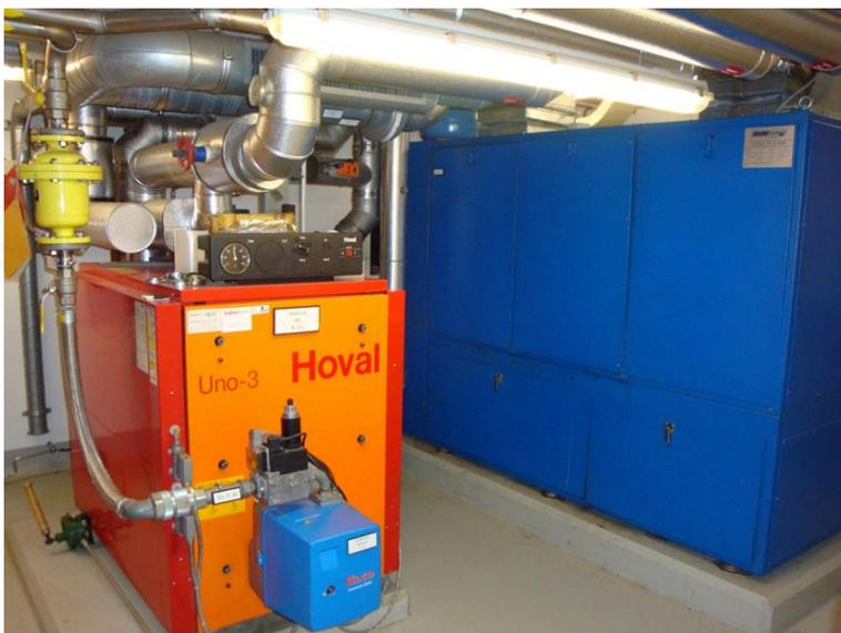
Heizung und Blockheizkraftwerk das im Jahr 2018 ersetzt wird
