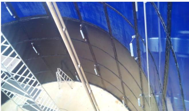
SB-Reaktor mit aufgetragener Beschichtung
